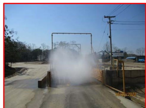
(16) ระบบสเปรย์น้ำล้างล้อรถบรรทุก
